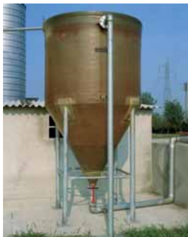
Sedimentatore-Decantatore per reflui di lavorazione, capacità 7 m 3 . Sedimentator-decanter used for machining reflows, capacity 7 m 3 . Absetzbecken-Dekanter, für Verarbeitungsrückführung, Kapazität 7 m 3 .
