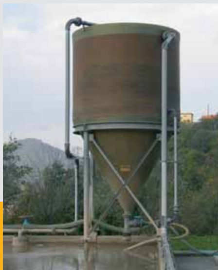
Sedimentatore-Decantatore per liquami, capacità 13,8 m 3 . Sedimentator-decanter used for sewage, capacity 13,8 m 3 . Absetzbecken-Dekanter, angewandt für Schmutzwasser, Kapazität 13,8 m 3 .
